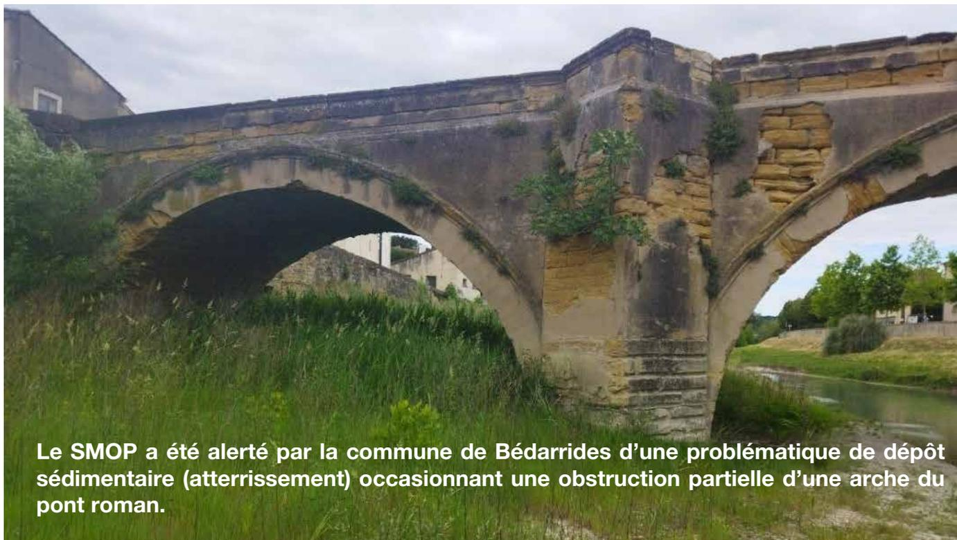
En réponse, et après instruction d'un dossier au titre de la loi sur l'eau, le SMOP a procédé à l'ouverture d'un chenal d'écoulement permettant la remise en fonction de l'arche située en rive gauche du pont.
