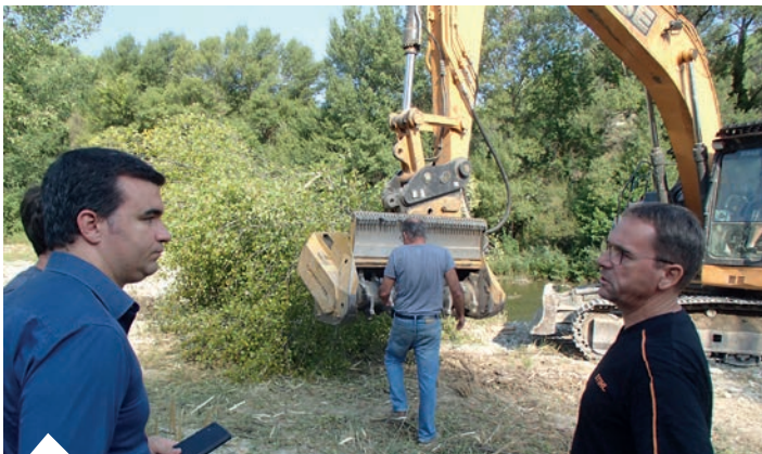
SUIVI DU CHANTIER DE SCARIFICATION DU LIT DE L'OUVEZE SUR ENTRECHAUX
