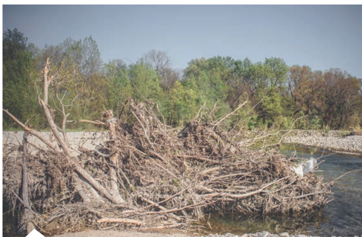
EMBÂCLES SUR L'OUVÈZE À ROAIX APRÈS LES CRUES DE 2019
