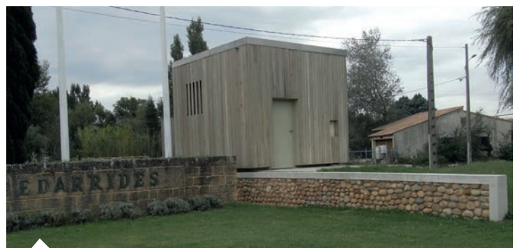
STATION DE POMPAGE DES VERDEAUX À BÉDARRIDES
