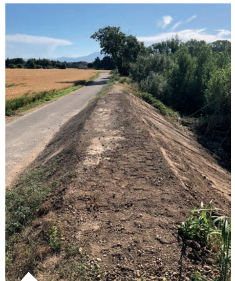
REMISE EN ÉTAT DE LA DIGUE DE FOURNIGUIÈRES, BÉDARRIDES
