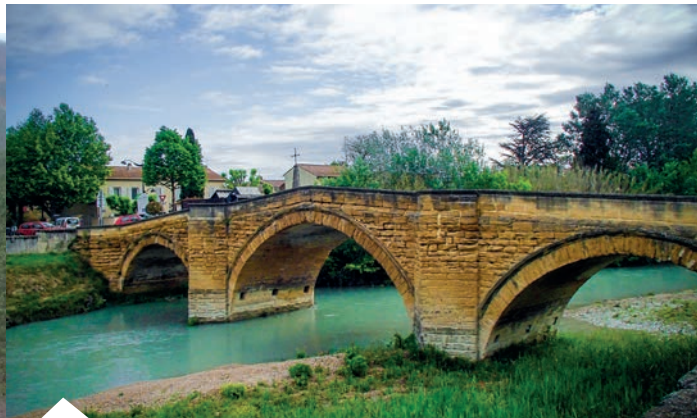
ATTERrissement AU PONT ROMAN DE BÉDARRIDES
