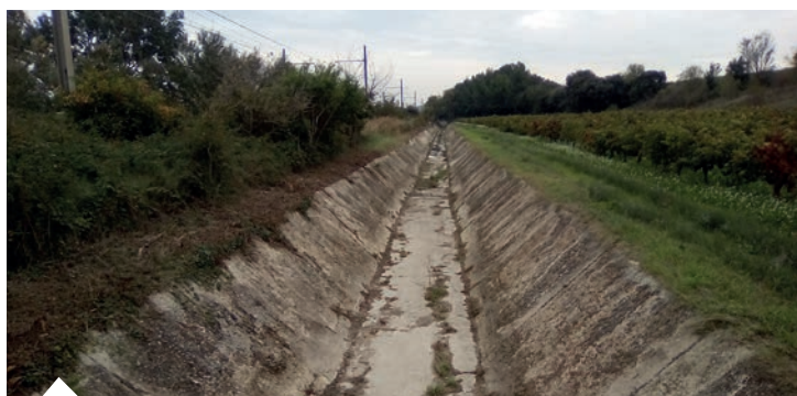
CANAL DE LA CONTRE-SEILLE, UN OUVRAGE VÉTUSTE
